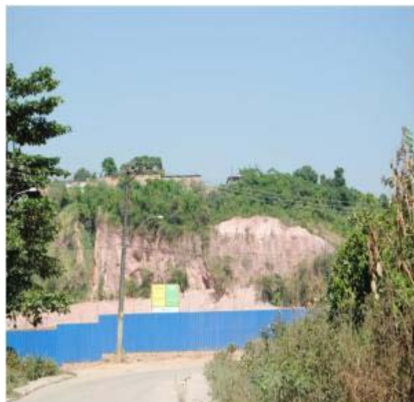
Figuras 5.1.32 e 5.1.33 – Duas áreas próximas, nas quais se notam desmoronamentos em taludes verticais abandonados após exploração de material de empréstimo. Na foto 111, o tapume cerca um conjunto de residências em construção. Vistas a partir das coordenadas UTM 669.821/7.483.130
