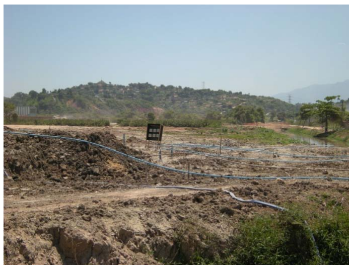
Figura 5.1.7 – Área da comporta 2 (rio Sarapuí) onde a profundidade do nível freático encontra-se entre 3 e 4 metros e está sendo rebaixado através de bombeamento para profundidade de 18-20m. UTM: 670541//7482350.
