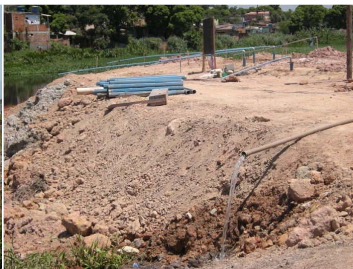
Figura 5.1.8 – Detalhe da operação de bombeamento para rebaixar o nível do lençol freático. UTM: 670541//7482350.
