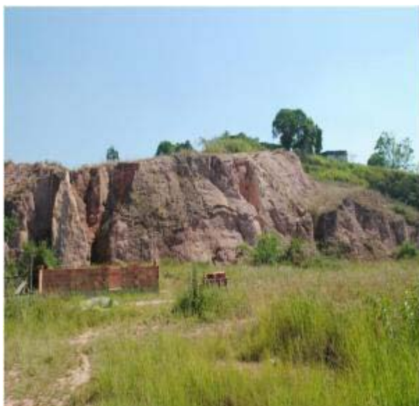
Figuras 5.1.32 e 5.1.33 – Duas áreas próximas, nas quais se notam desmoronamentos em taludes verticais abandonados após exploração de material de empréstimo. Na foto 111, o tapume cerca um conjunto de residências em construção. Vistas a partir das coordenadas UTM 669.821/7.483.130
