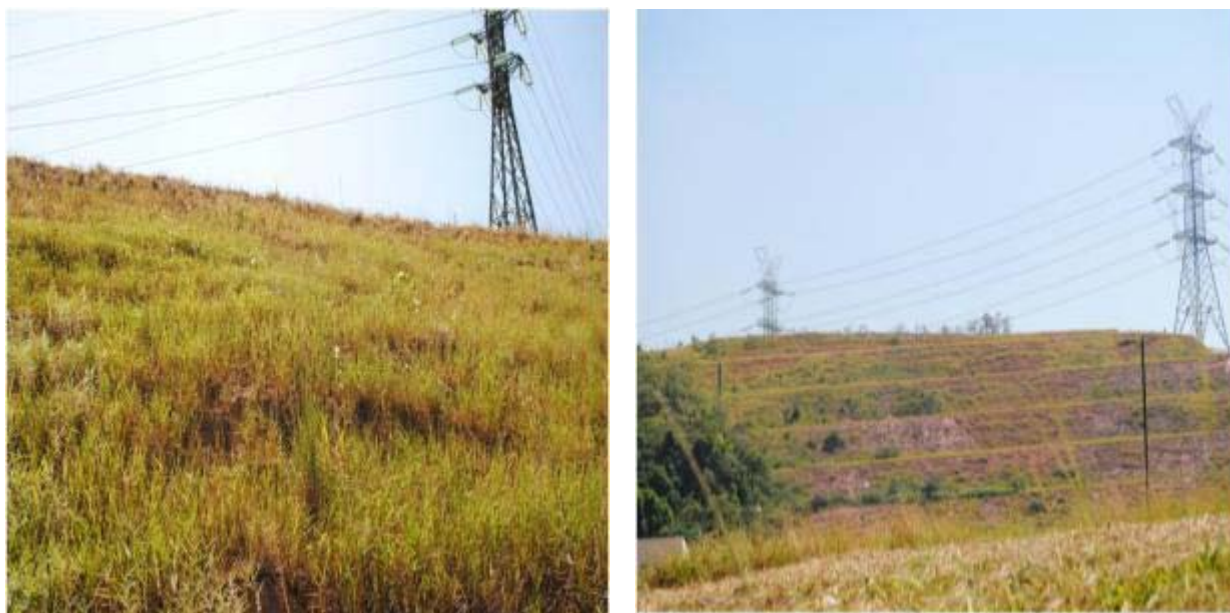
Figuras 5.1.34 e 5.1.35 – Encosta recuperada e taludes escalonados em vias de recuperação na Subestação de Furnas no município de Belfort Roxo. Vistas a partir do local de Coordenadas UTM 670984/7483234
